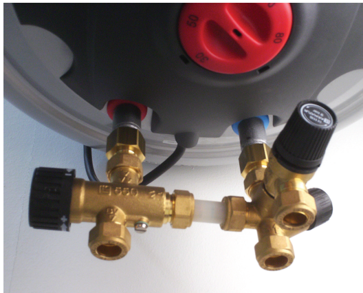
LK Armatur varolaiteryhmä termostaattisella sekoitusventtiilillä
