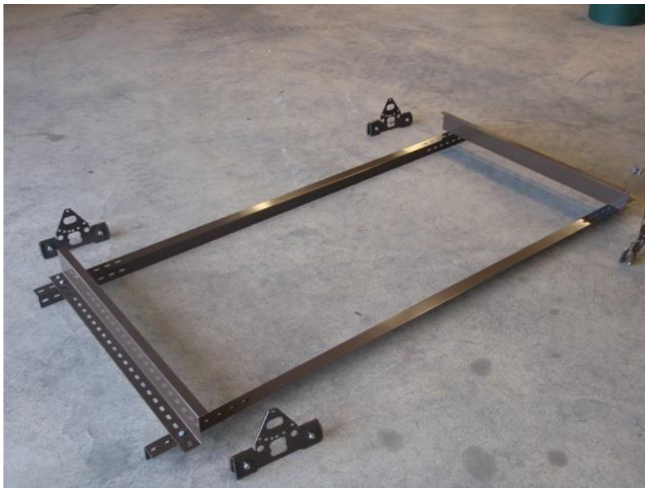
Kerääjän asennuskehikko kasattuna. Päätökappaleet asetetaan siten, että niiden pystyseiniä väliin jäävän kerääjän tilan pituus on 2 m.
