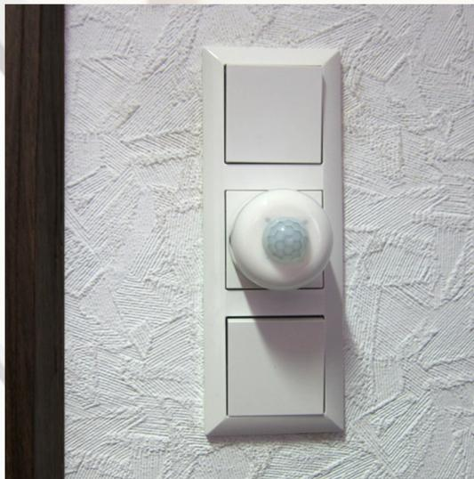
dS Stecker-PIR Sensor eingesteckt in Steckdose
