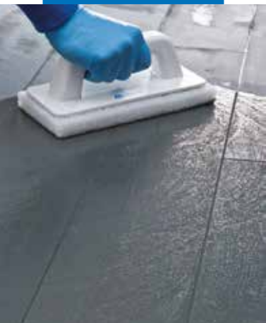
Puoliksi kovettuneen saumauksen puhdistus Scotch-Brite®-hankauslevyllä
