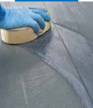
Saumojen puhdistus ja viimeistely sienellä ja viimeistely kovalla selluloosasiemenellä
